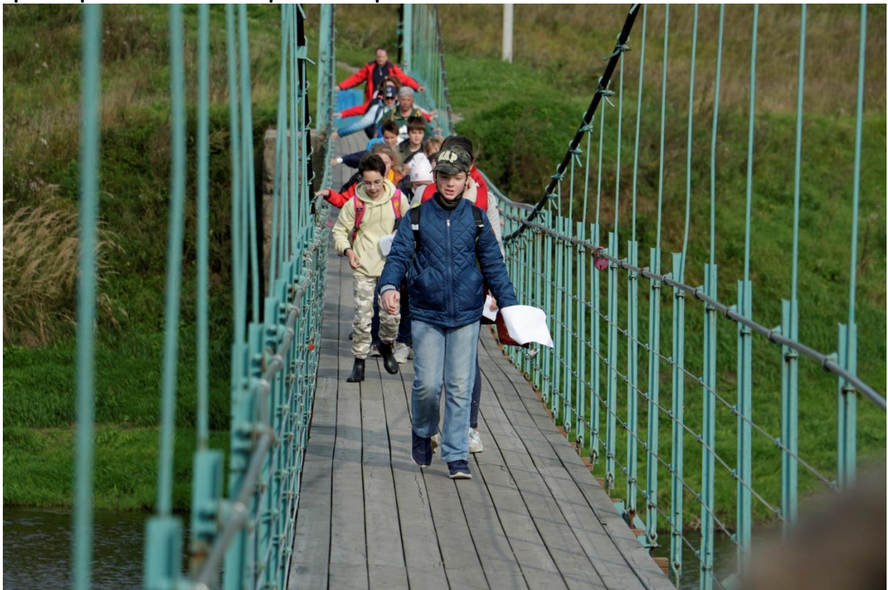
Мы идём по подвесному мосту.
